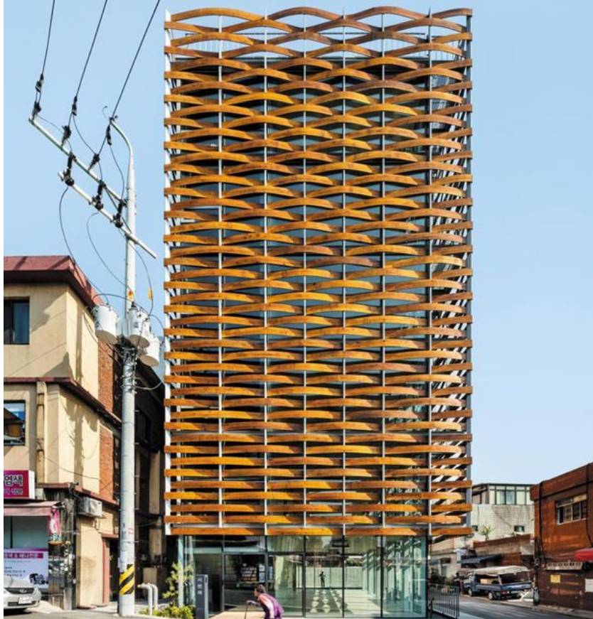
서울 구로동의 근린생활시설 '서편재'. '작은 나무 서(櫛)' '역을 편(編)'으로 '나무가 엮어진 집'이라는 뜻이며, 얇게 가공한 적삼목을 건물 외부에 둘렀다.
