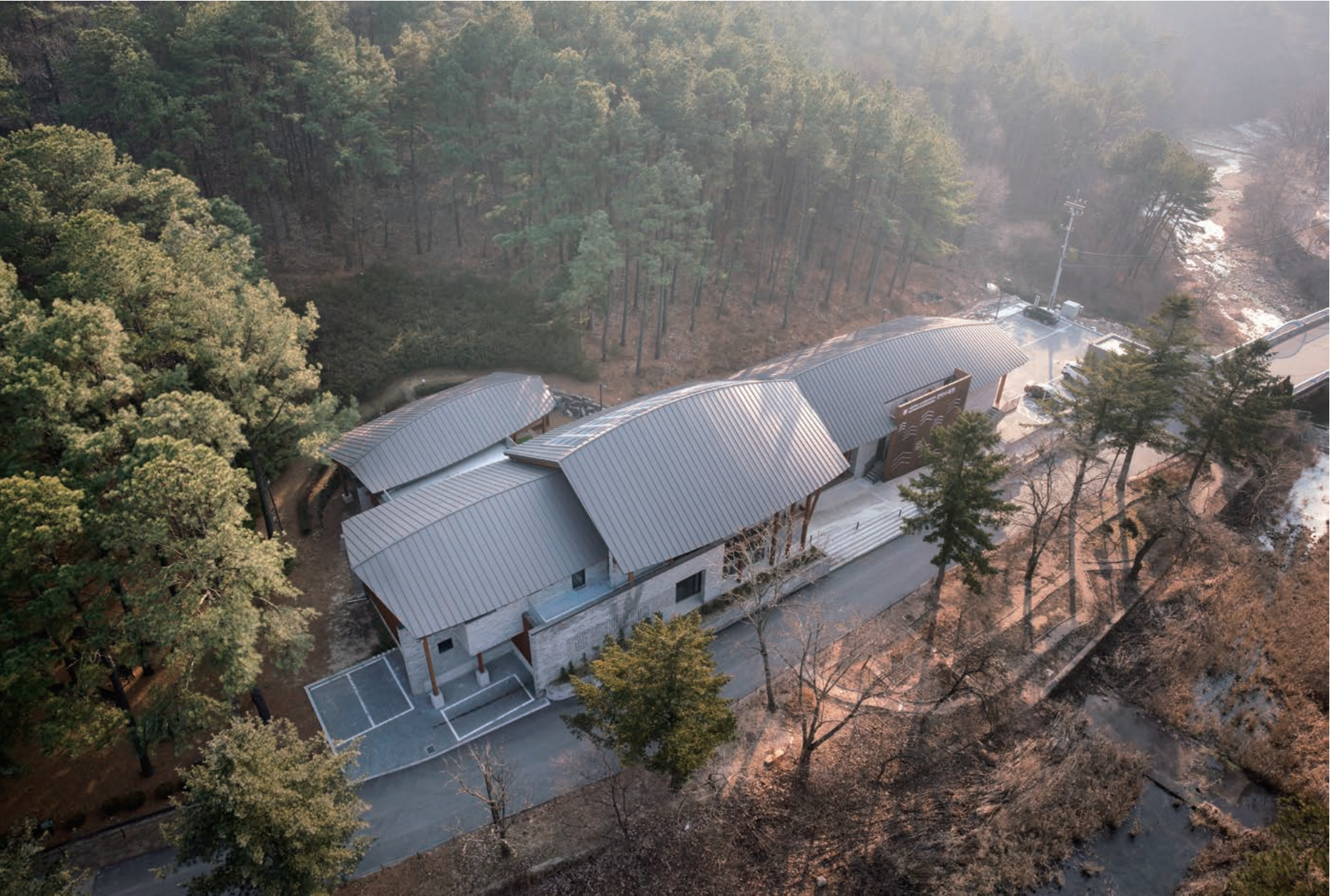
관악산 능선을 닮은 자연스런 지붕선을 실현하기 위해 그래스호퍼 플러그인을 사용한 매개변수 디자인 모델링 기술을 이용했다. The architect used a parametric design modeling technique with a Grasshopper plug-in, to realise a natural curved roof line that resembles the Gwanak Mountain ridge.
