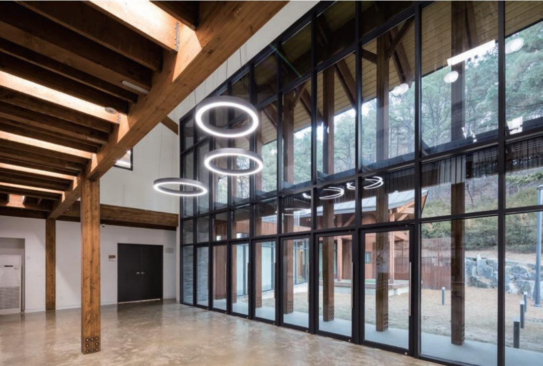
이 건물은 단위 목조구조 부재들에 의해 만들어지는 퇴, 칸이라는 공간구성의 단위로 시작한다. The building begins with a unit of spatial composition called a 'to', 'kan' made by the members of the lumber structure unit.
